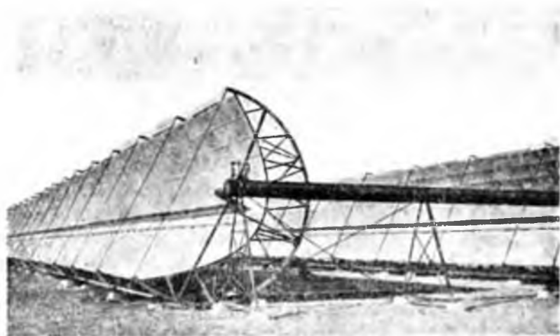
Рис. 18. Зеркало солнечной машины (в Миди, вблизи Каира) спереди.
